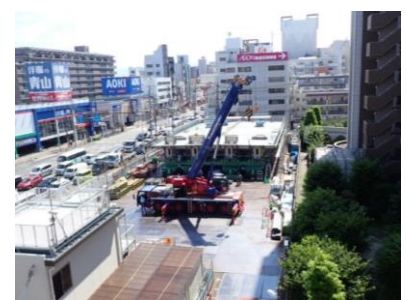
鋼製橋桁中央径間 組立状況 (2024年7月)
