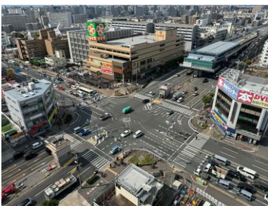
既設橋梁 撤去状況 (2024年3月)
