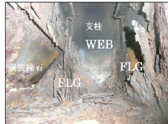
腐食損傷内部
