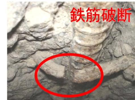
➤ 水和反応で生成される水酸化アルカリと特定のシリカ鉱物の反応によりコンクリートに異常な膨張と、それに伴うひび割れを発生させ、鉄筋の破断に至る損傷が発生している
