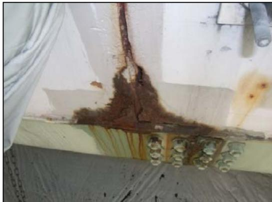
腐食損傷外観
