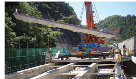
プレストレストコンクリート床版への更新
