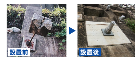
設置前 設置後 損傷しているアンカー アンカーの追加設置
