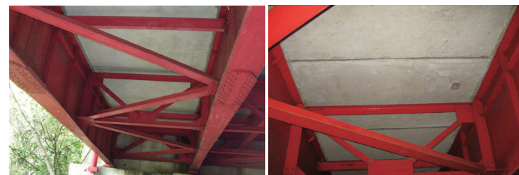
取替を実施した床版下面の状況(雄の山第1橋 下り線)
