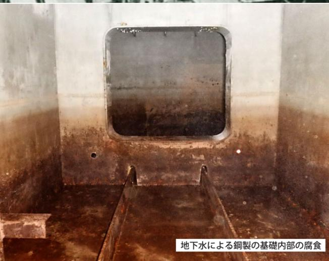
地下水による鋼製の基礎内部の腐食
