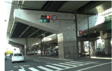
【対策例】 鋼板による補強・ 表面保護
