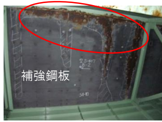
補強鋼板の腐食
