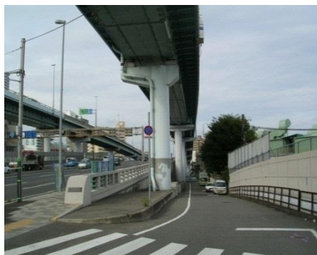
国道2号と側道の状況
