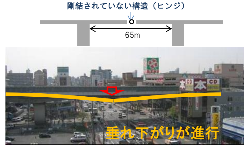
橋の中央ヒンジ部において、路面の垂れ下がりが進行
