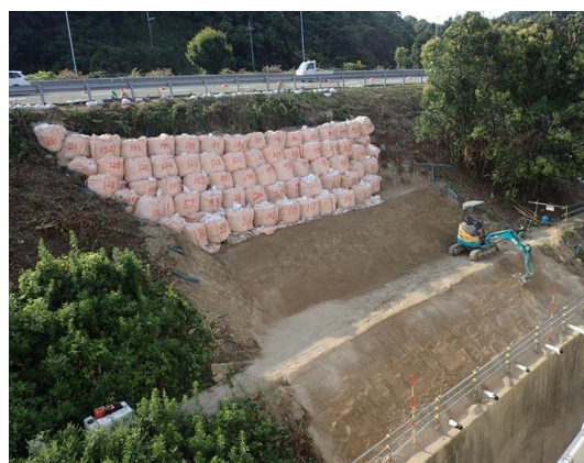
写真-1 大型土のうによる応急復旧状況
