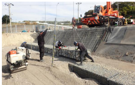
写真-2 吊り式かご枠設置状況
