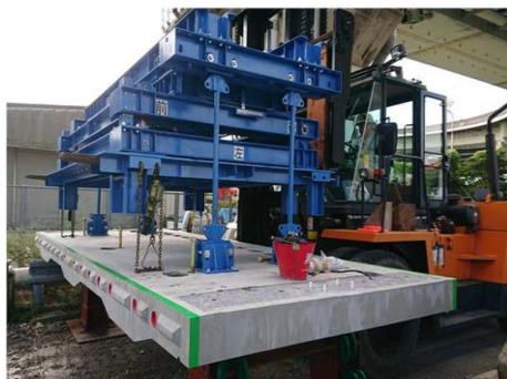
写真-4 芯出し装置
