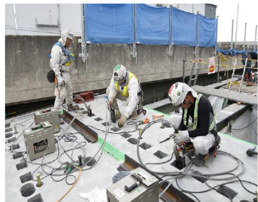
写真-6 PS ジョイント構造の締付け状況
