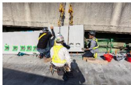
写真-2 PCa 壁高欄
