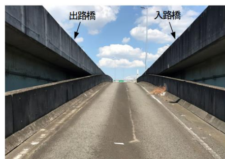
写真-1 試験施工前の状況
