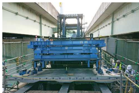
写真-3 PSジョイント床版架設状況
