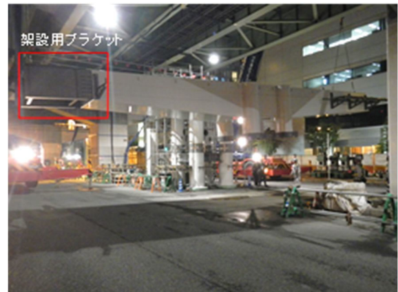
写真-3 低空頭での架設状況
