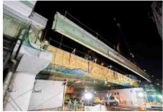
写真-14 G1 桁の吊り降ろし
