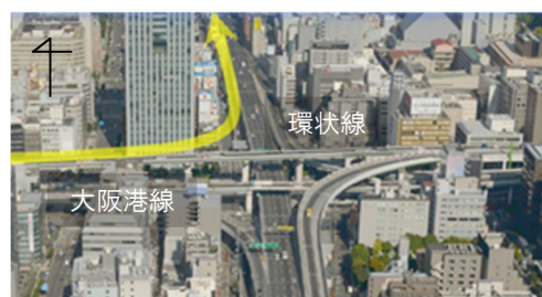
写真-1 信濃橋渡り線橋梁付近
