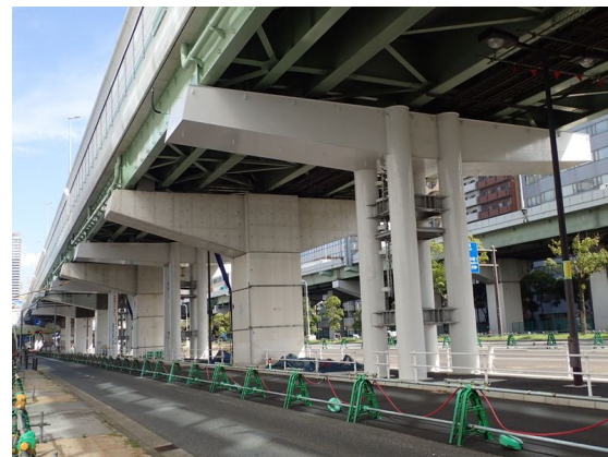
写真-4 完成した鋼管集成橋脚
