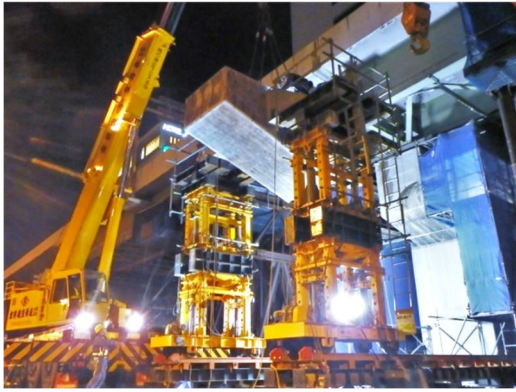
写真-8 既設 RC 橋脚梁部撤去
