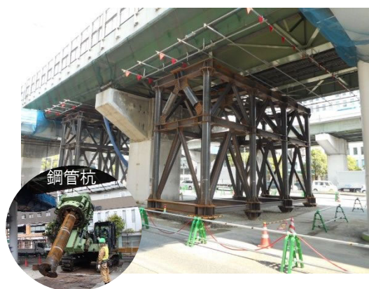
写真-6 仮受け構台の設置状況
