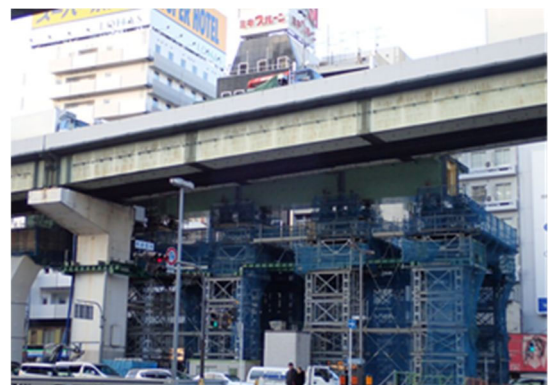
写真-11 立体ラーメンベント（B5～B8）
