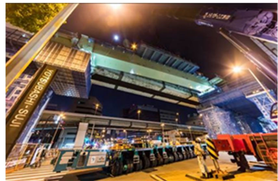
写真-12 550t 吊りクレーンによる一括架設
