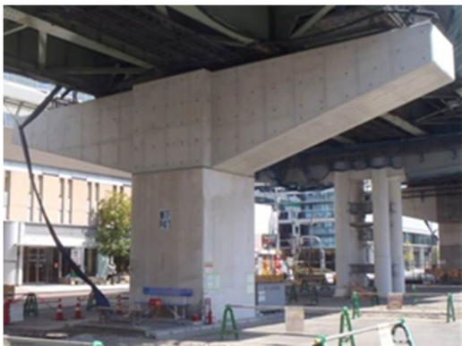
写真-10 梁再構築完了後
