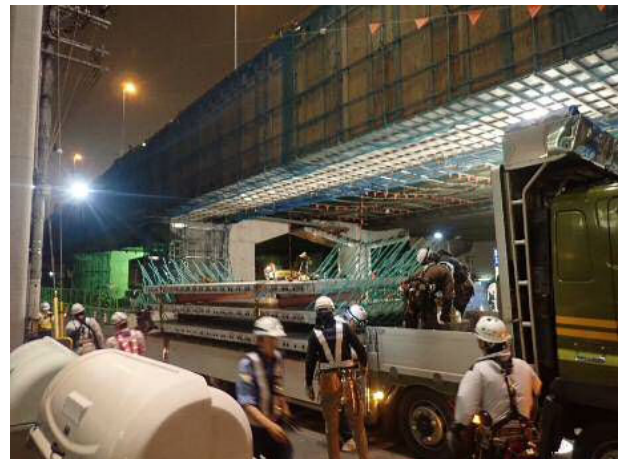
写真-16 ワッフル型 UFC 床版の運搬
