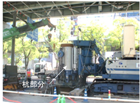
写真-2 杭施工 (アルファーステム工法)
