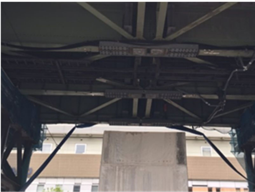
写真-9 既設 RC 橋脚梁撤去後
