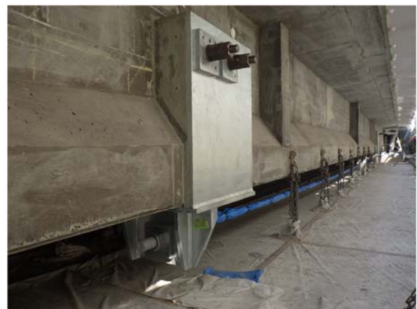
写真-2 外ケーブル設置状況
