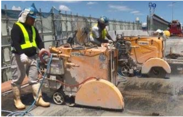
写真-3 床版の一括切断
