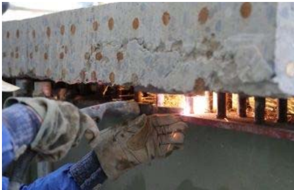
写真-4 スタッドの切断
