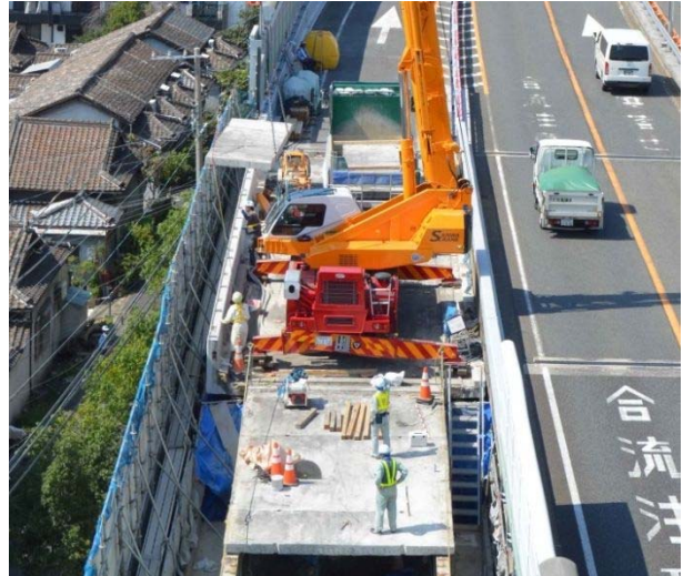
写真-5 隣接径間からの床版撤去 (25t クレーン使用)
