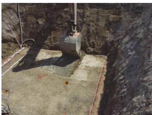
写真-3 バックホウによる表面の施工状況確認
