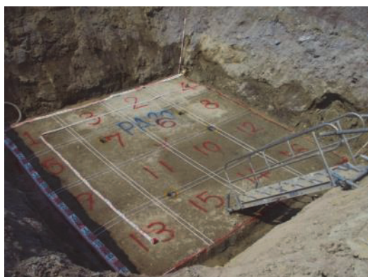
写真-2 施工区画の割付とコアボーリング位置
