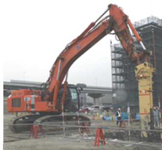
写真-1 施工状況
