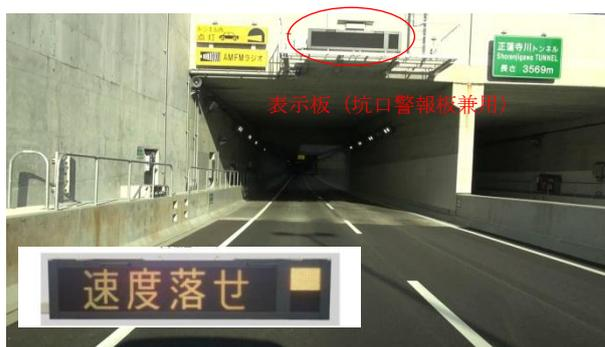
写真-2 表示板設置状況と警告表示の内容
