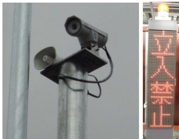
写真-4 センサと拡声装置（左）及び表示板（右）
