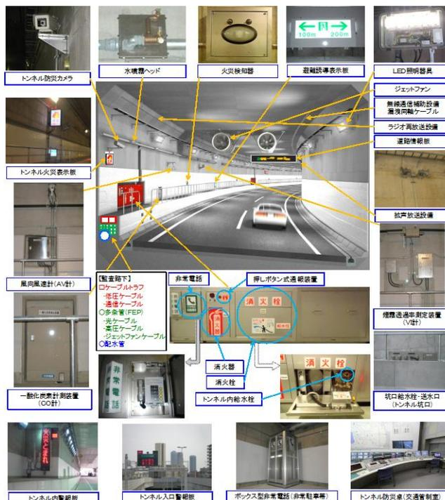
図-7 正蓮寺川トンネル防災設備イメージ図
