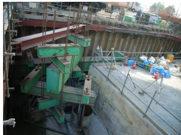
写真-2 載荷試験状況
