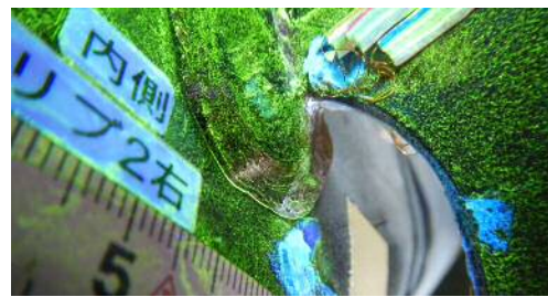
(ii) 載荷回数 10 万回でリブ 2 に発生したき裂
