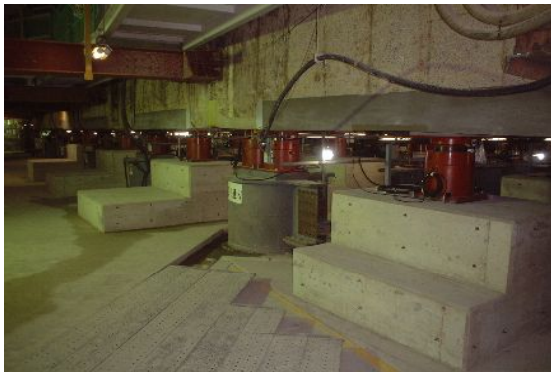
写真-1 縦断梁撤去後台座構築状況
