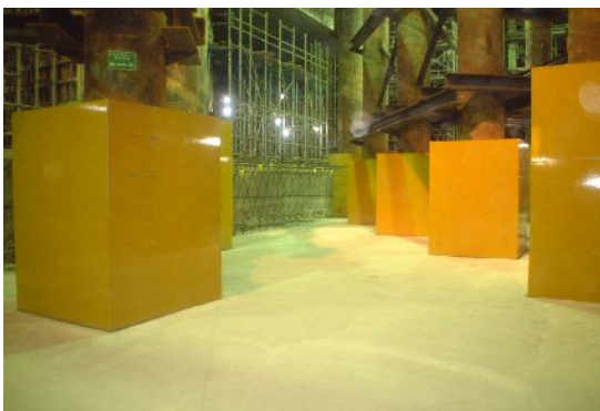
写真-2 底版部仮受箱抜き状況
