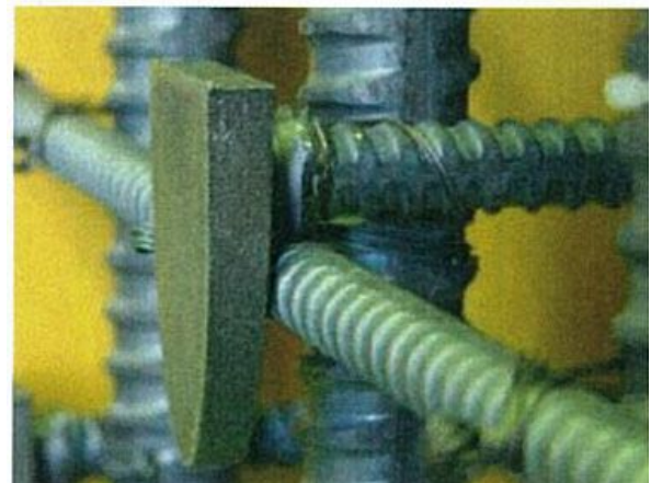
写真-6 プレート定着型せん断補強筋
