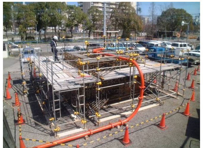
写真-4 実物大供試体によるコンクリート充填性確認試験
