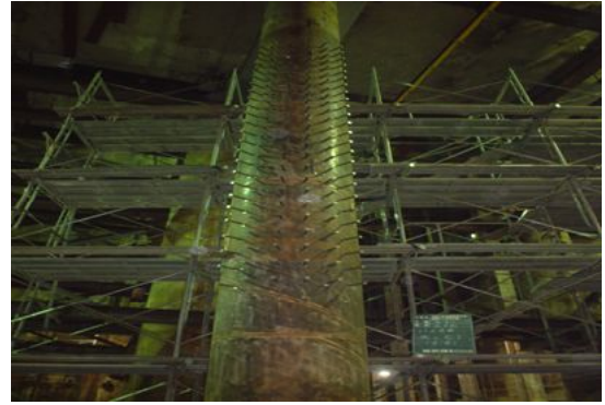
写真-3 側壁に抱き込まれる仮受杭の処理
