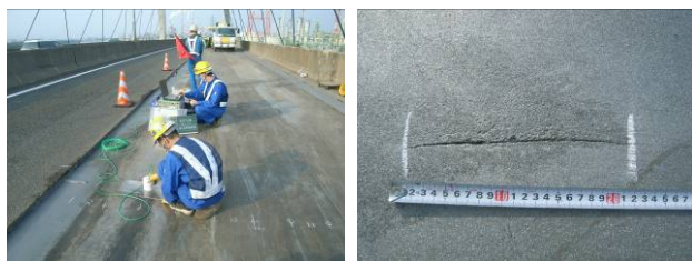
図-14 現地空間リフトオフ試験状況
