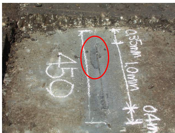
図-4 デッキ上面オーバーフロー状況
