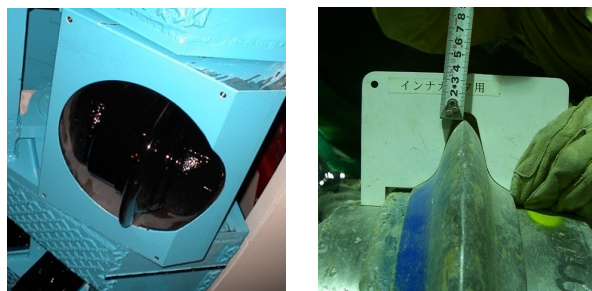
写真-2 岩盤部掘削前後のローラカッタ
