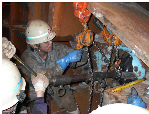
写真-3 ローラカッタ取付状況
