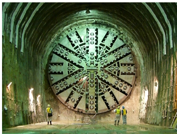
写真-4 シールド機到達状況
