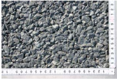
写真-1 1工区 (乾燥, OWP) の路面状況
