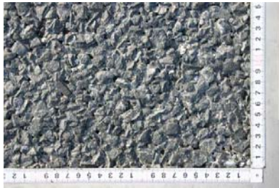
写真-2 3工区 (乾燥, OWP) の路面状況
