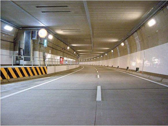
写真-1 神戸長田トンネル（基本部）
