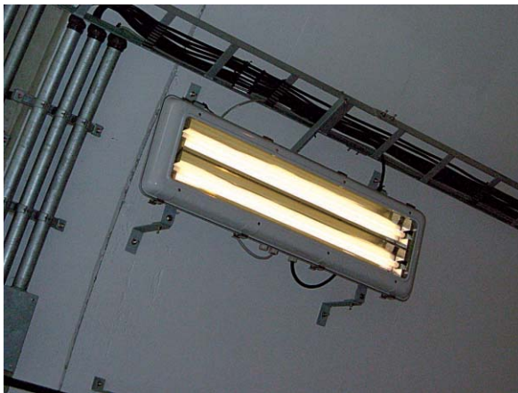
写真-2 32W Hf 蛍光ランプ（電球色）× 2灯用トンネル照明器具
