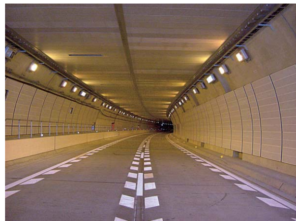
写真-3 神戸長田トンネル（入口部）
