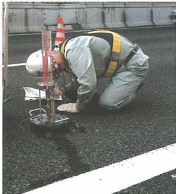
写真-1 現場透水試験状況
