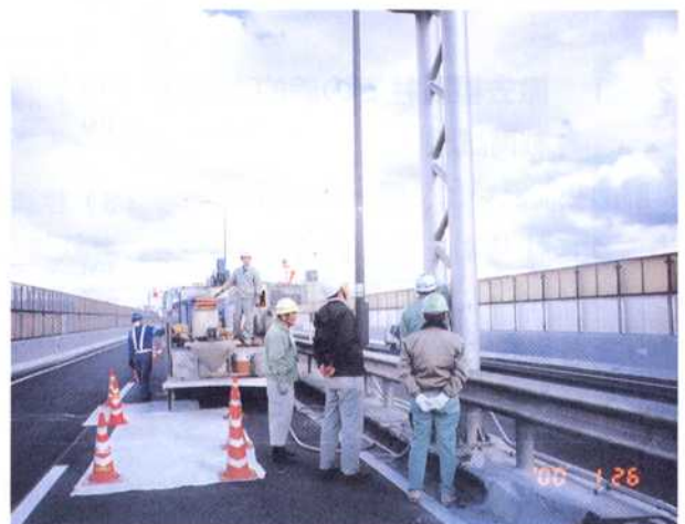
写真-2 実橋での試験施工
