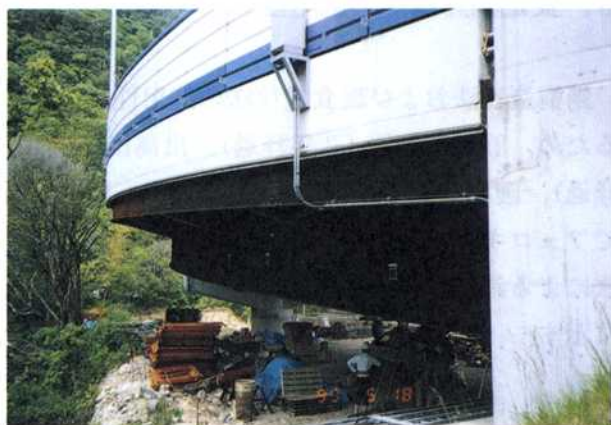
写真-1 安定錆促進工事施工後の様子 (橋台付近が試験施工部、奥が未施工部)
