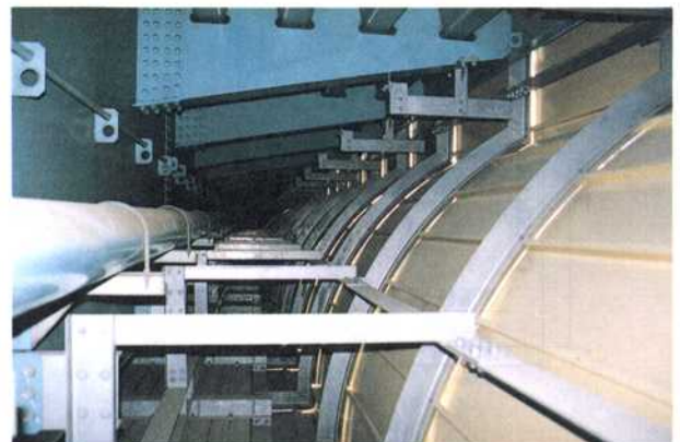
写真－5 側面板取付け状況（箱桁部）
