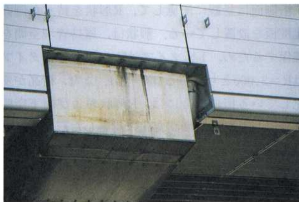
写真-7 橋脚周りの遮音ゴム設置状況
