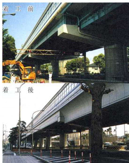
写真-1 高架裏面吸音板設置前後の状況
