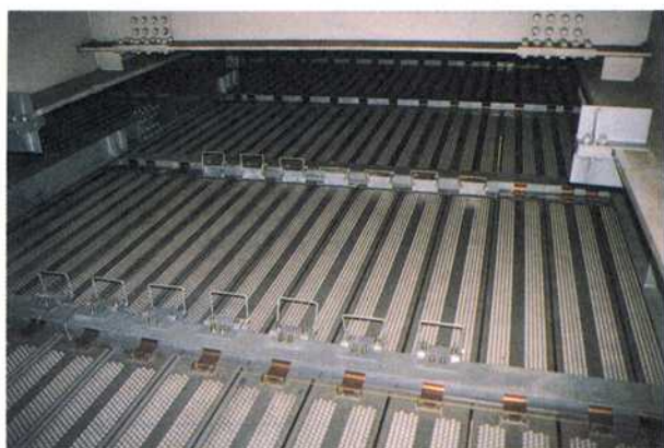
写真-6 開口パネルの設置状況
