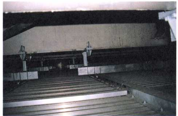
写真－4 維持管理用空間
