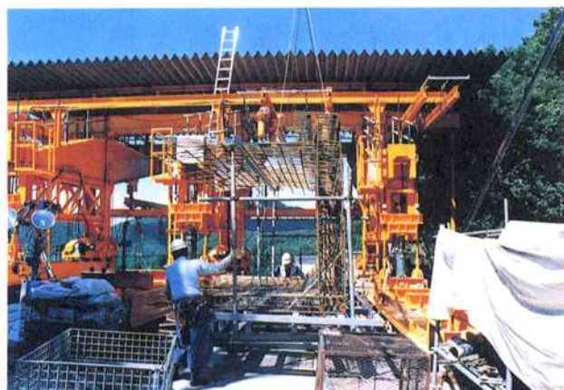
写真-1 主桁鉄筋ユニットの据え付け
