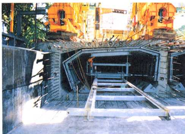
写真-2 主桁内部の型枠支保工
