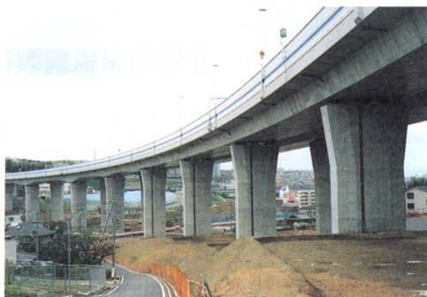
名谷高架橋完成写真
