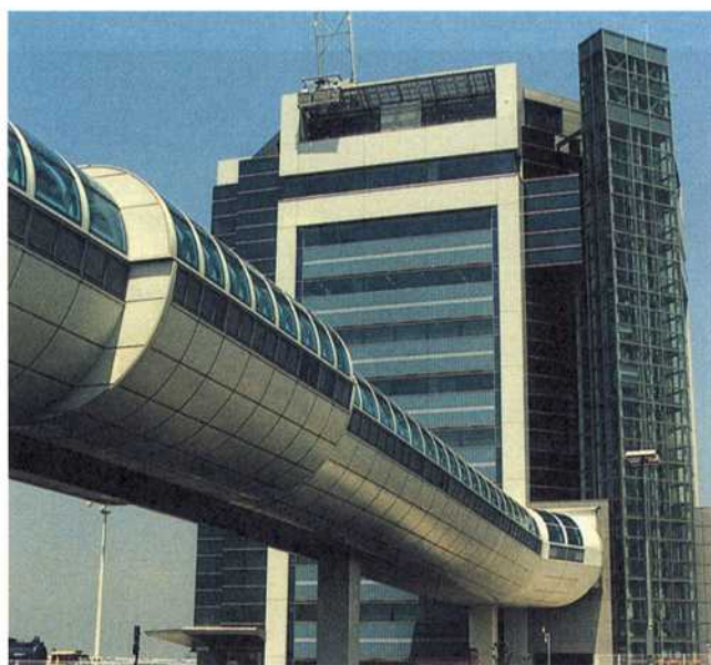
写真-3 連絡通路橋の外観
