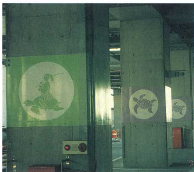
写真-7 浦島太郎のキャラクターを配置した2階駐車場の柱
