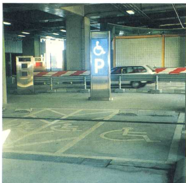
写真-5 身体障害者用駐車スペース
