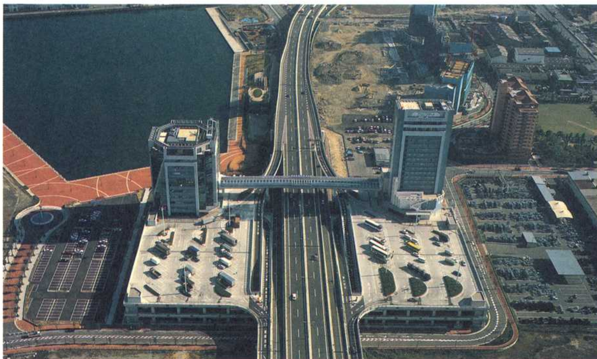
写真-1 泉大津パーキングエリアの全景
