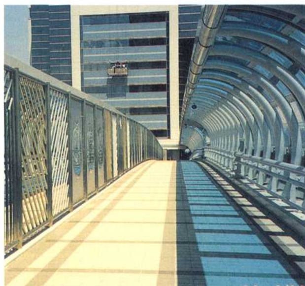
写真-8 ブルースカイブリッジ（連絡通路橋）
