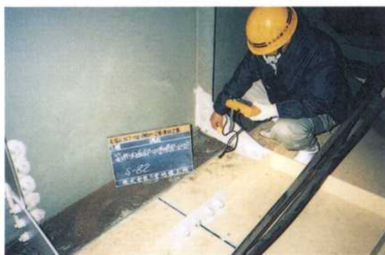
写真-1 パネル取付
