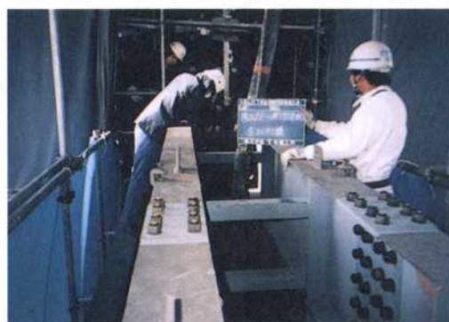
写真-4 中間鋼製梁取付け工
