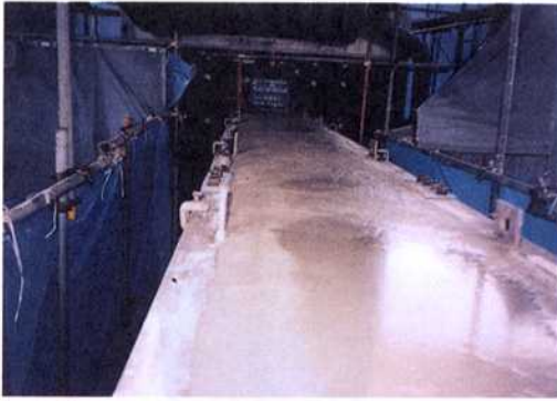
写真-5 中間鋼製梁充てんコンクリート打設
