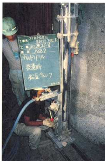
写真-6 あと施工アンカー用穿孔ドリル
