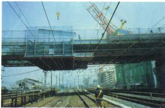
写真-10 軌道上での施工状況
