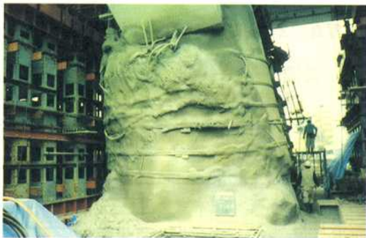
写真-3 神P688橋脚の二次災害防止対策
