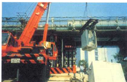
写真-5 梁ブロックの撤去状況
