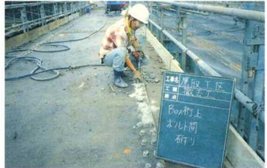
写真-9 RC床版撤去後の状況
