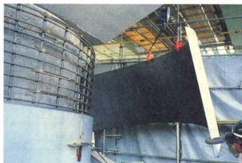
写真-7 鋼板設置状況
