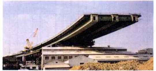
写真-1 送り出し架設状況
