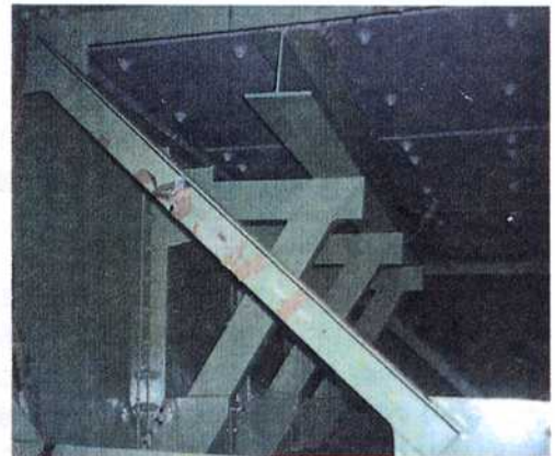
写真-3 床版補強工
