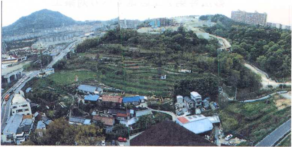
写真-1 工事着工前写真
