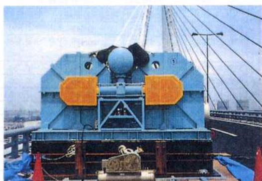
写真-1 起振機設置状況 (L/2 点)
