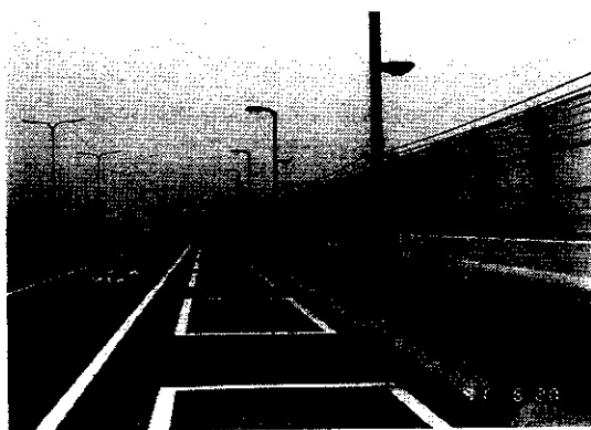
写真-2 歩廊部照明柱
