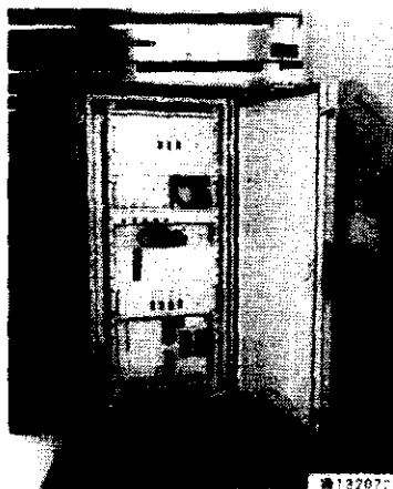
《写真-1》 外観写真
