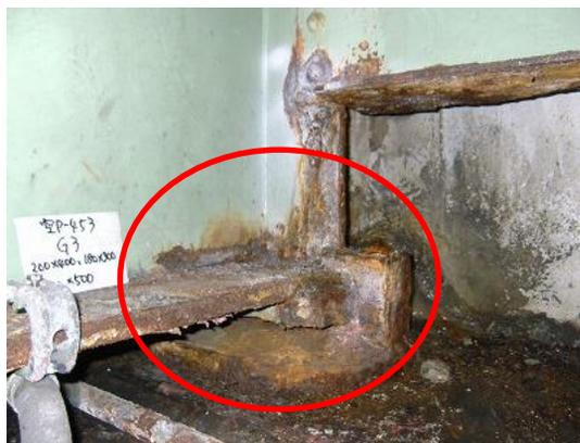
鋼桁端部の腐食による断面減少
