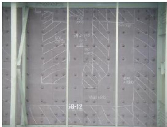
鋼板補強されたRC床版で不良音を確認された部位のチョーキング
