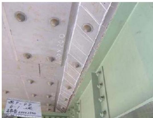
鋼板補強されたRC床版端部で不良音を確認
