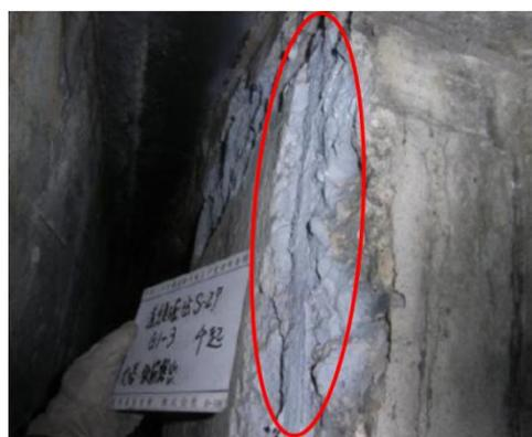
主桁の鉄筋露出
